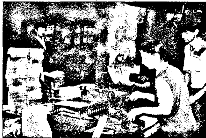
Se lucrează la curbarea unor subansamble. În planul doi, din cauza aburilor care scapă etanșării, abia dacă se disting celele de aburire. Căldura și umezeala domină în acest atelier, în ciuda sistemului de absorbție - ventilație, zice-se, bine pus la punct.
