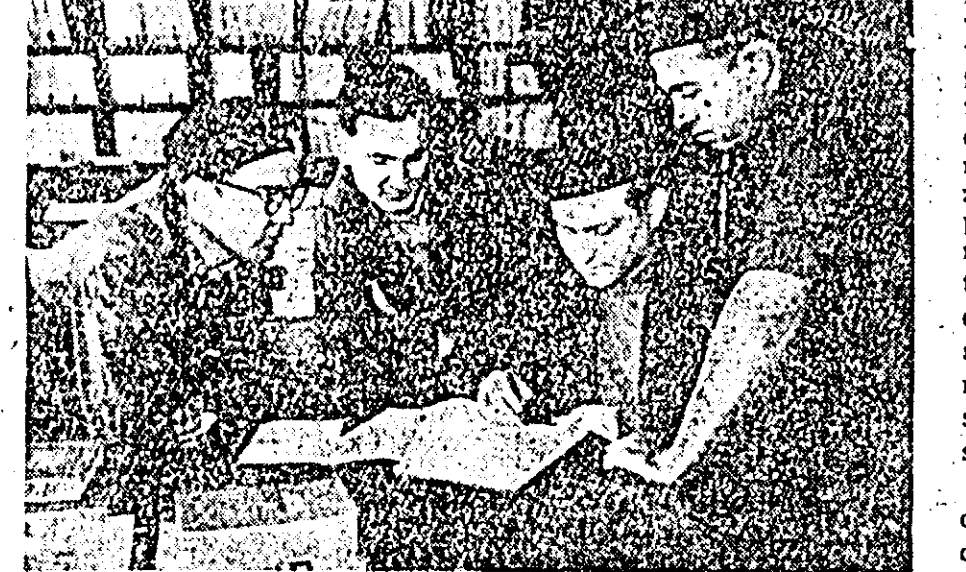
La biblioteca de cărți tehnice Lazăr Ardelean, Ladislau Molnar și Milan Popovici ascultă cu atenție explicațiile tov. Ing. Artur Szisz privind montarea mașinilor-unelte.
