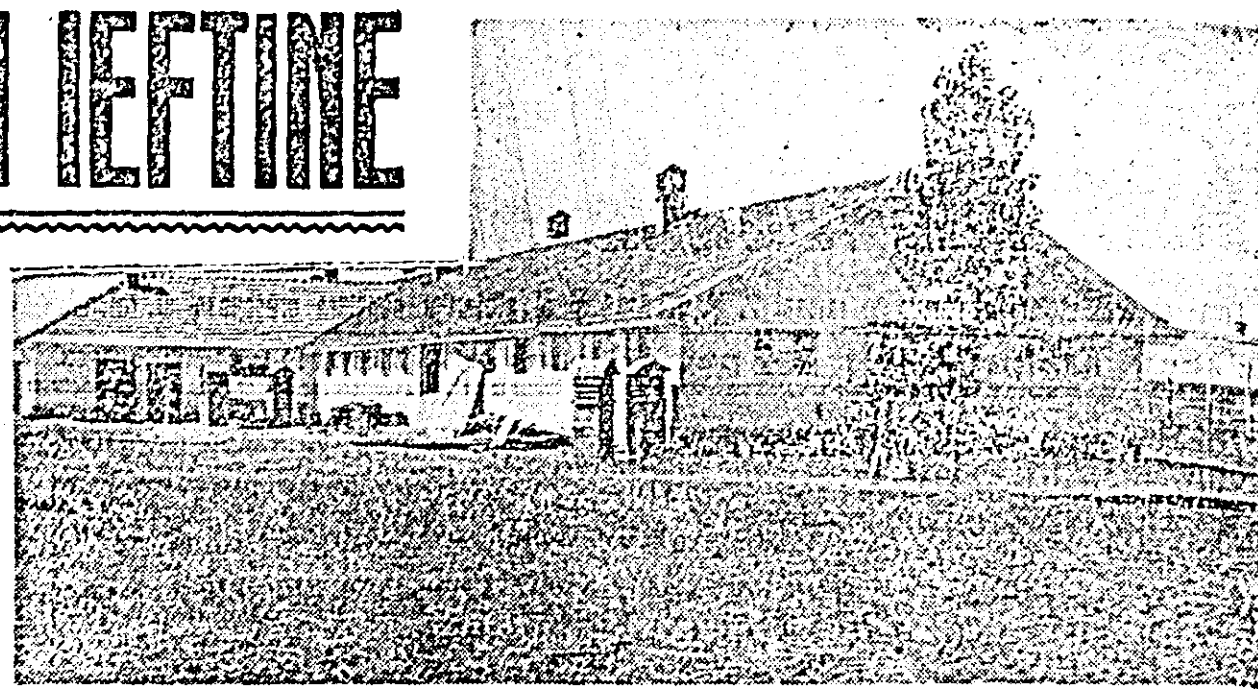
La gospodăria agricolă colectivă „23 August” din Curticei sa terminat recent construcția acestui spațios grajd pentru animale.
