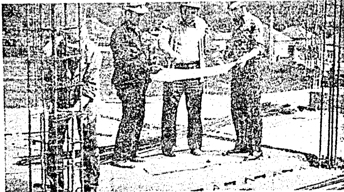
Secvențe de muncă de pe șantierul unui bloc de locuințe ce se construiește în Lipova.
