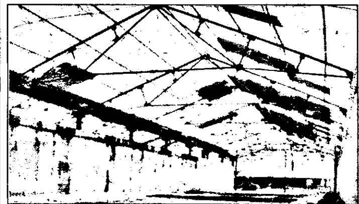
La fostul Complex de creștere a porcilor din Șiria, dacă altceva nu au putut fura (pereții fiind din beton) hoții s-au mulțumit ... și cu acoperișul.
