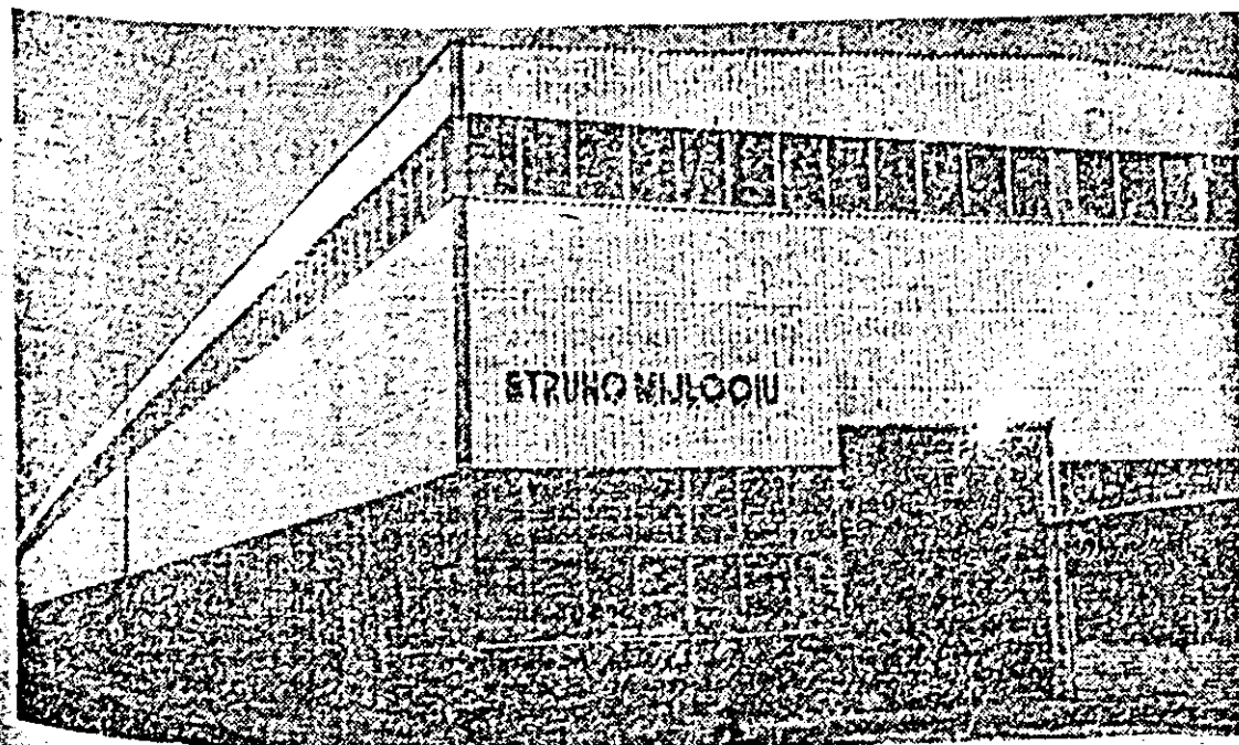
La nou obiectiv în peisajul întreprinderii de strunguri: hala de fabricație a strungurilor mijlocii.
