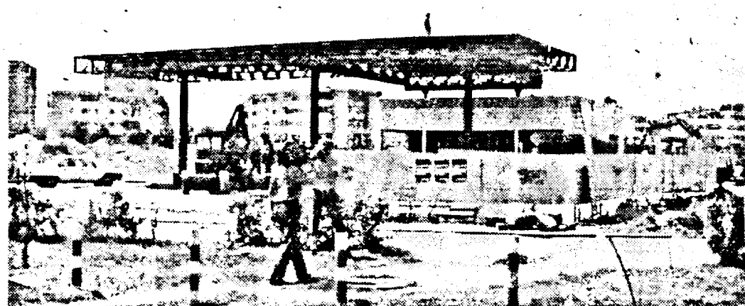
Benzinăria din Zona 300, la care se lucrează. În spatele ei, chiar dacă nu se văd încă, primarul zice că se vor vedea multe. Vom reveni atunci.
