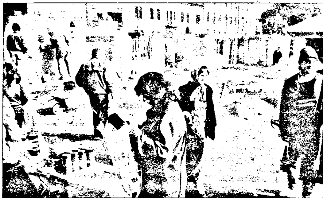
Deși a început de câteva luni bune, construcția spațiilor comerciale în Piața Mihai Viteazul se desfășoară cu încetinitorul. În acest timp, zeci de comercianți ambulanți își oferă marfa pe tarabe improvizate, în condiții neigienice, de promiscuitate chiar.
