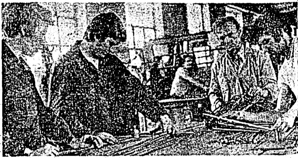
Aspect de la secția prefabricate a I.J.C.M.
