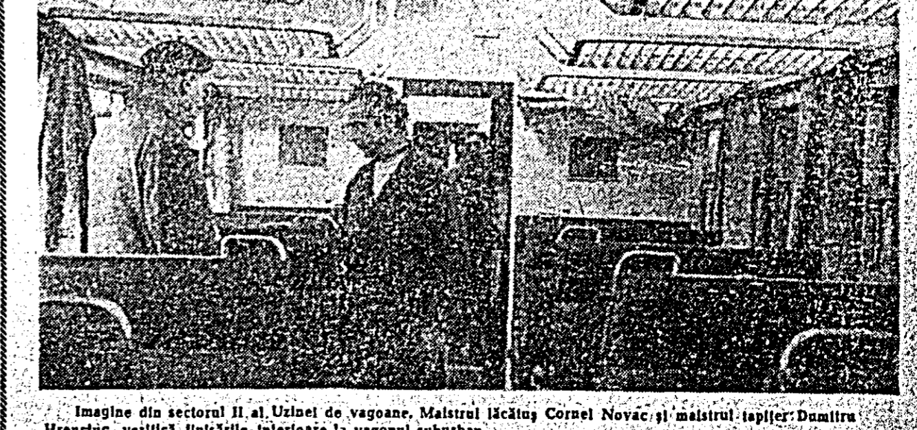
Imagine din sectorul II al Uzinei de vagoane. Meistrul lăcătuș Cornel Novac, și meistrul tapier Dumitru Hreucuc, verifică înălțimile interioare la vagonul suburban.
