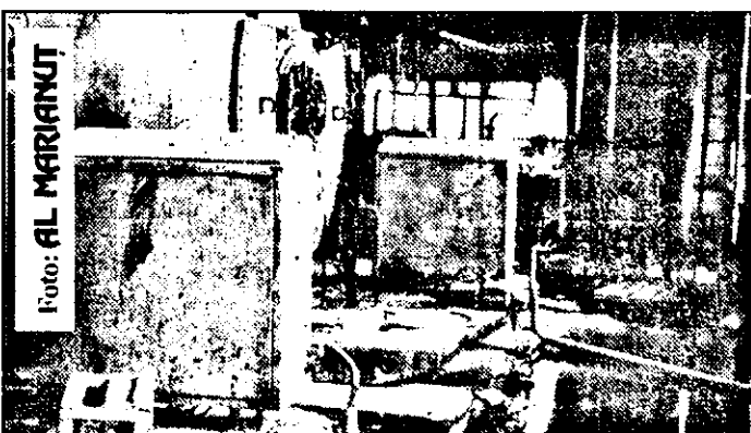
Utilajele sunt părăsite, descompletate și distruse...
