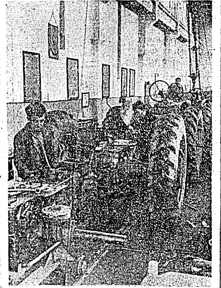
În atelierul unic al stațiunii de mașini și tractoare din Pecica reparațiile la tractoare sint în plină desfășurare. ÎN CLISEU se execută reparația la transmisia motorului la tractoare.
