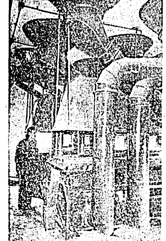
Una din instalațiile în care se face calibrarea porumbului.
