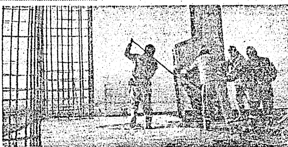
Pe șantierul noului termocentrale arădene, constructorii de la A. C. Ind. înscriu, noi realizări în bilanțul întrecerii socialiste. Foto: M. CANCIU
