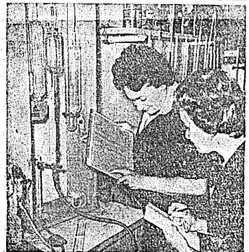
In laboratorul Uzinei de strunguri, Ing. Stela Poroan și tehniciana Georgeta Holman lucrează atent la determinarea conținutului de carbon în oțeluri și fontă.
