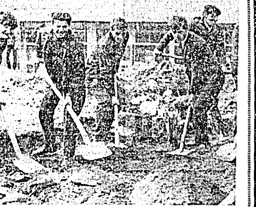
Instantaneu de pe șantierul muncii voluntar-patriotice din Pia- ța gărilor, unde elevii Școlii de șoferi duminică au efectuat peste 900 ore de muncă. Foto: M. CANCIU
