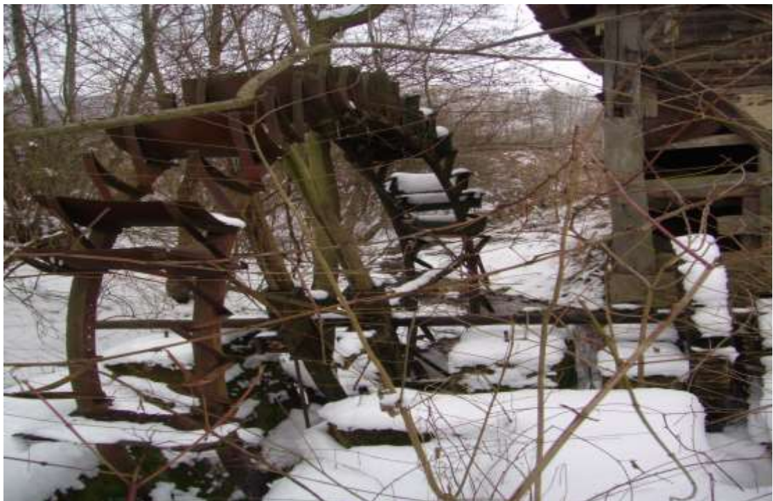
Roata Morii Comănești 1 – construcție de lemn cu zbaturi
