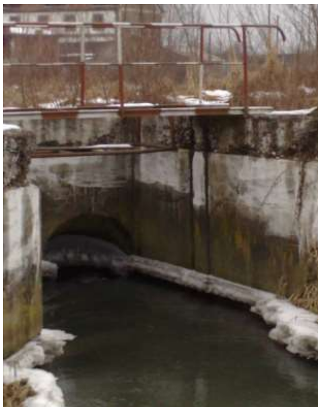
Sifonul de subtraversare a Văii Hodișului
