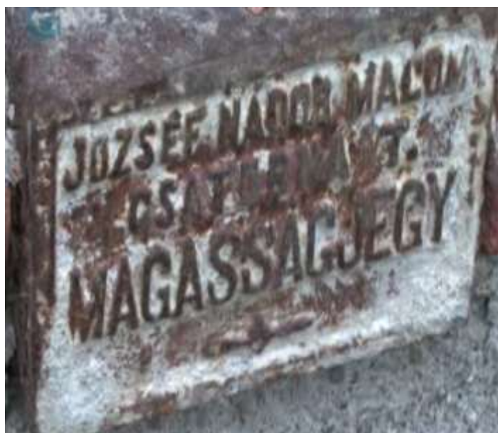
Placă de cupru cu inscripționarea cotelor de nivel
