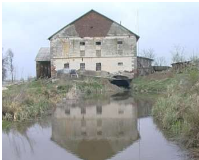
Moara Bălucana, canalul de aducțiune la ieșire
