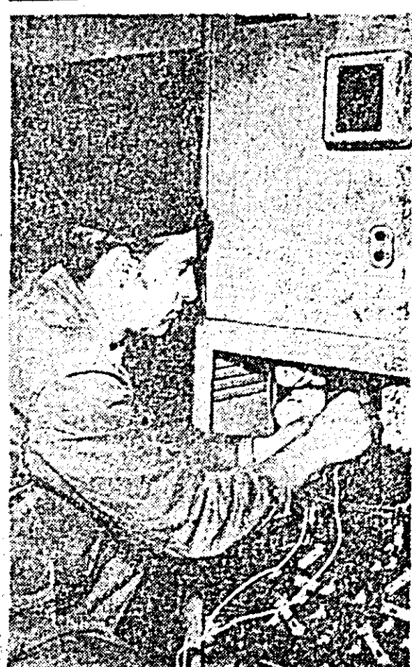
Stația CFR Arad. Atenți și conștincioși ca întotdeauna, șeful postului de electricieni, Stelian Ana, verifică stația de redresoare.
