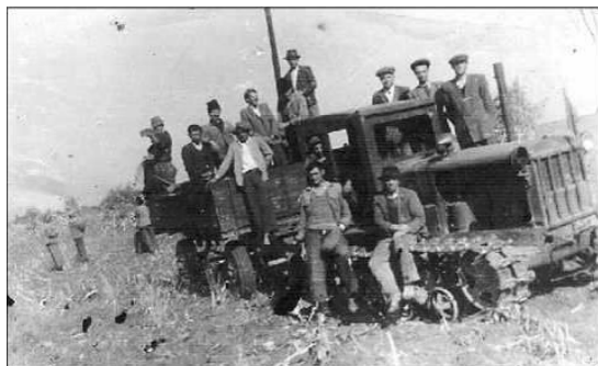
Lucrări de introducere a curentului electric pe drumul Curtici-Macea – 1952
