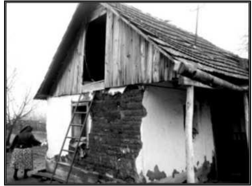
Sobiță cu pod gata să se huluie – 1975
