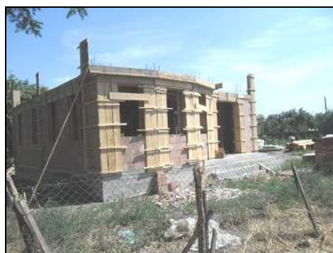
Casă nouă în construcție
