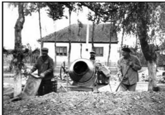
Maistori la betonieră – 1969
