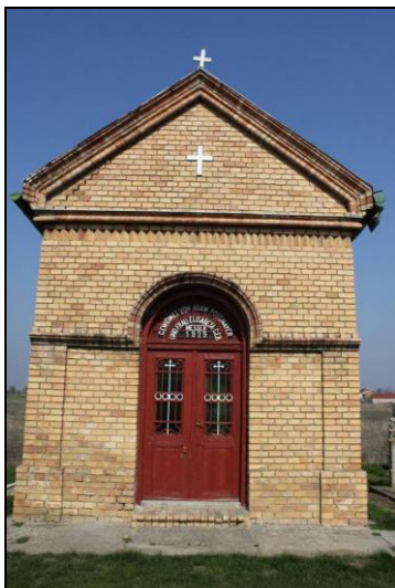
Capela (exterior și interior) 1929
