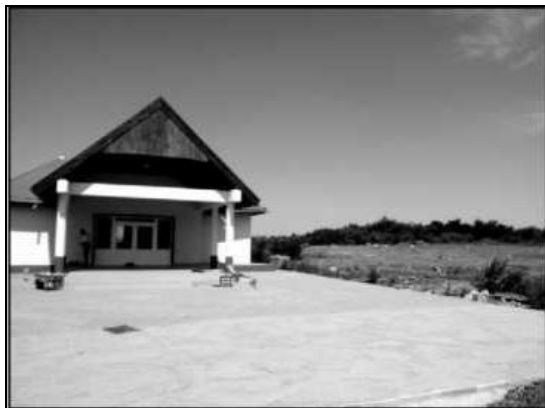
Capela nouă –Cimitirul Ortodox Satu Bătrân, 2013
