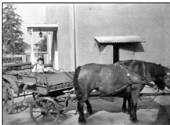
Cai înhămați la hinteul Primăriei – 1981
