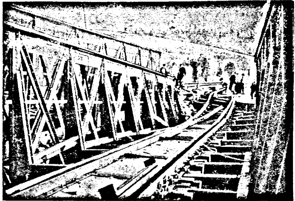
Unser Bild zeigt die Verheerungen welche ein Bombenanschlag auf der Brücke in Böcklamarkt, wo das Eisenbahngelände in die Luft gesprengt wurde, angerichtet hat. Zwei Genbrücken, die bei der Brücke Baue...
