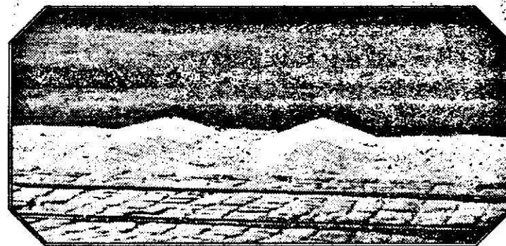
„Dacă Primăria s-ar îngriji de drumuri, eu nu aș fi nevoit să mai fac denivelări din beton!” - declară cu seninătate „proprietarul” acestor denivelări ridicate în mijlocul străzii M.Kogălniceanu după „patentul Moiescu”.
