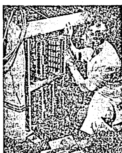
Mașina cehoslovacă de calculat ARITMA poate efectua într-o oră 8.000 operații de înmulțire sau 4.000 operații de împărțire.
