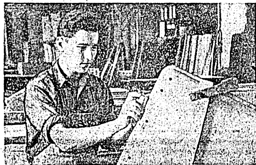
ÎN CLISEU: Utemistul Ioan Csak, curățînd profilele grele din partea de sus a dulapurii cu trel-uși, executate din furnir „păr african”.
