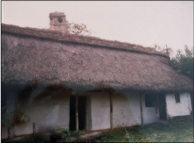
Casă veche cu acoperiș de trestie și târnaț deschis
