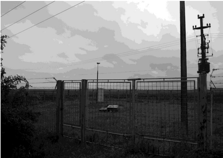
Foto 3. Perimetrul sanitar care delimitează un foraj din frontul de captare al apelor de adâncime
