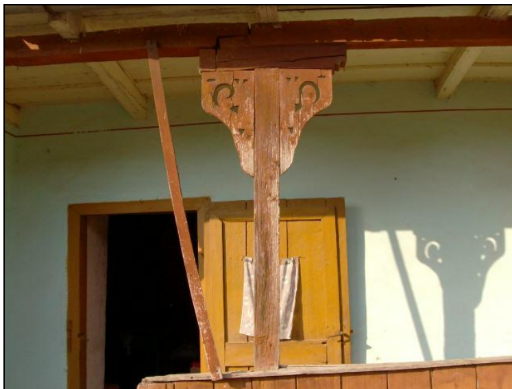
Stâlpi de târnaț din lemn ornamentați cu traforaje
