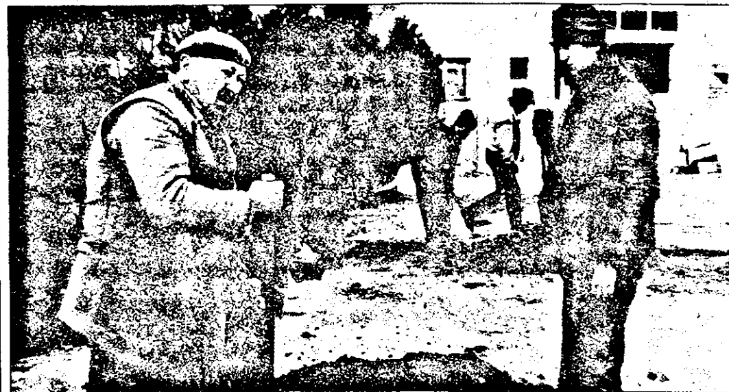
În curtea imobilului ce va găzdui judecătoria și procuratura se lucrează intens. Câte trei la o groapă... !?
