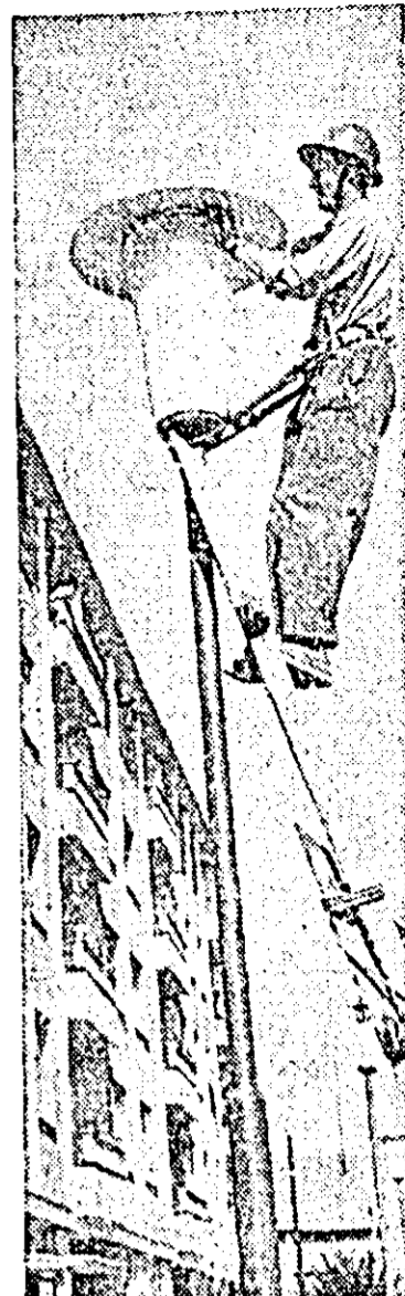
În cvartalul Podgoria se montează noile lămpi fluorescente.
