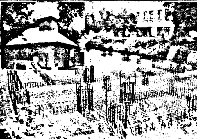
In loc să se înalțe ziduri, peste fundația bisericii ortodoxe Șega 2 (UTA) au năpădit buruienile, iar credincioșii se înghesuie în capela... Până când vor sosi banii, singurii care se bucură în voie sunt țânțarii ce se strâng la apa ce bălțește acolo.
