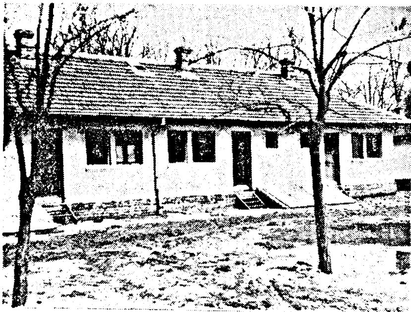
La Gospodăriile Agricole de Stat, ca și la Stațiunile de Mașini și Tractoare, muncitorii agricoli au din ce în ce mai bune condițiuni de viață: locuințe igienice, băi, cluburi, biblioteci, cantine, etc. Fotografia arată un colț al locuințelor muncitorilor agricoli dela Gospodăria Agricolă de Stat „Scânteia” dela Șimand.
