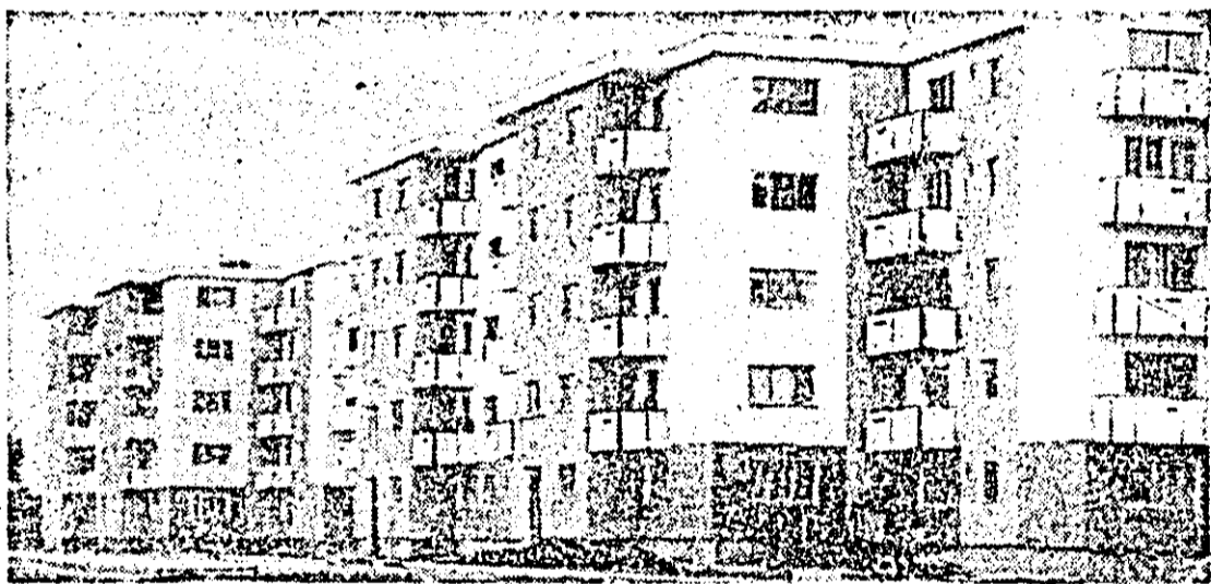
Noi blocuri de locuințe în cartierul Micalaca.
