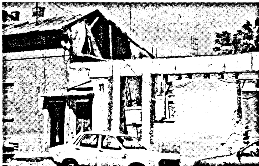
Casa din stânga imaginii a fost afectată de construcția de alături
