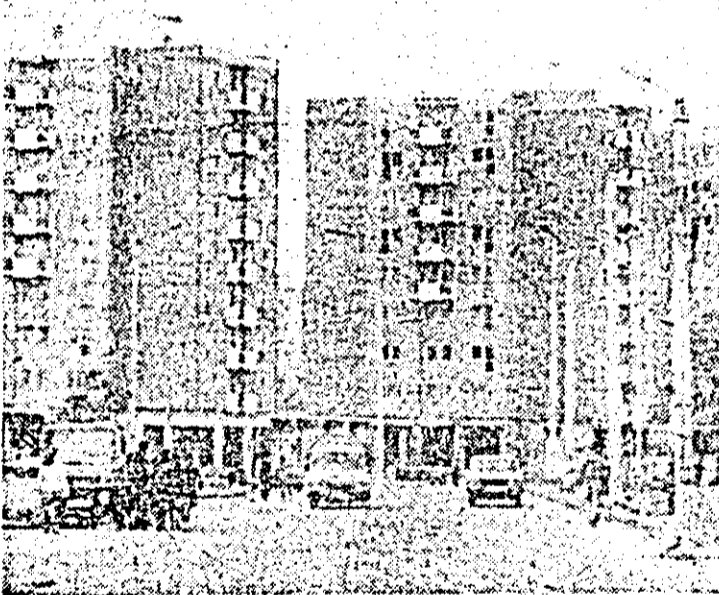
In construcție noi blocuri de locuințe în Piața UTA. Foto: M. CANCIU
