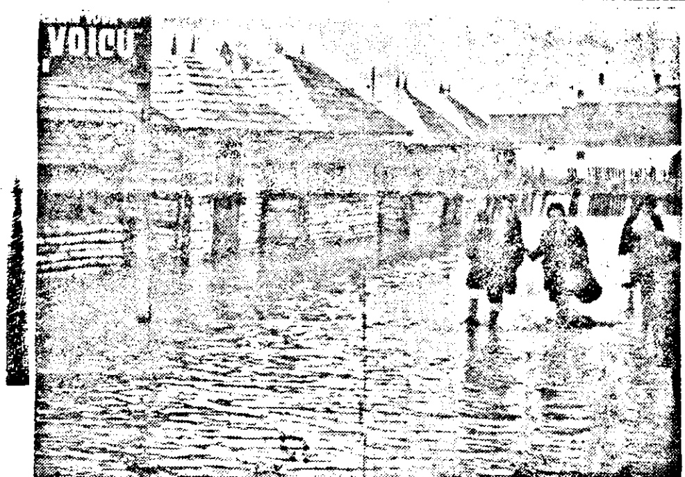
Ueberschwemmung in Bucevesti
