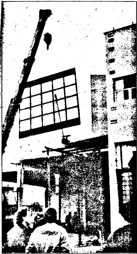
Aproape în întregime fabrica a fost construită după metode moderne cu care constructorii români operează de mulți ani - prefabricatele (din beton sau metalice) sau chiar elemente spațiale.
