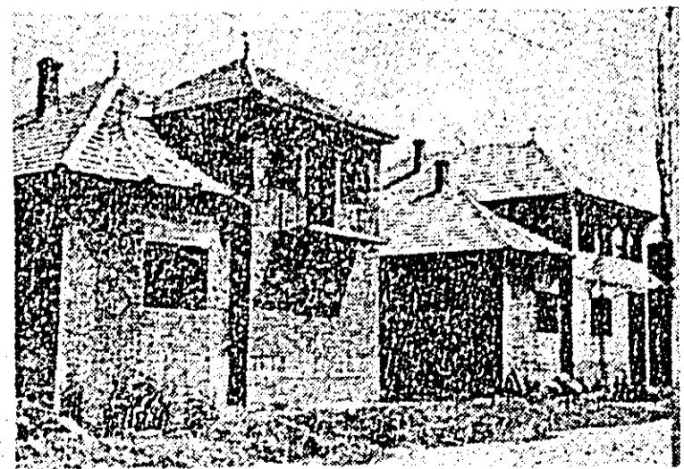
Noi case cu aspect urban, proprietate personală, se ridică în Ineu. Constructor — secția de specialitate a cooperativei de consum din localitate. Asemenea construcții s-au înălțat cu sutele în acești ani de bogat avînt edificar.
