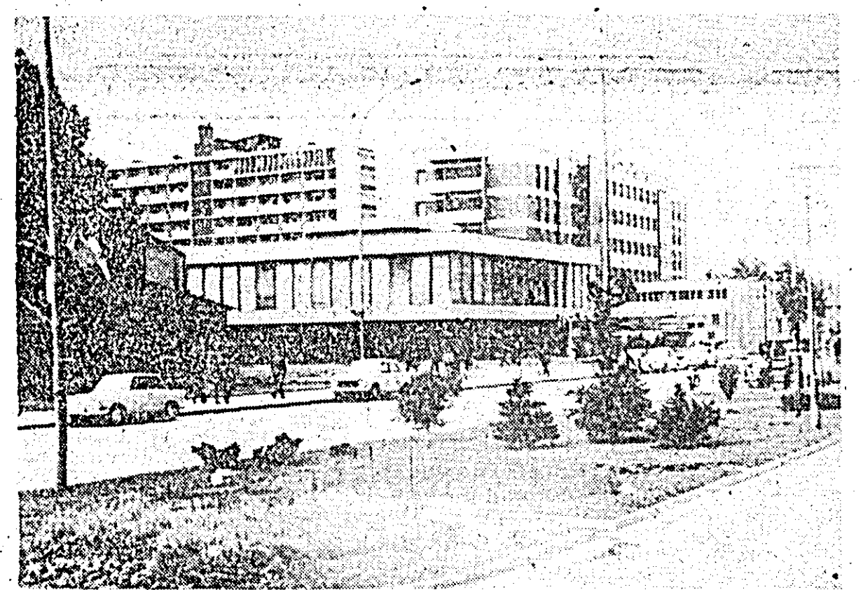
Vedere exterioră a hotelului „Belgrad” recent construit la Leskovac — oraș de munte și centru al industriei textile sârbești.
