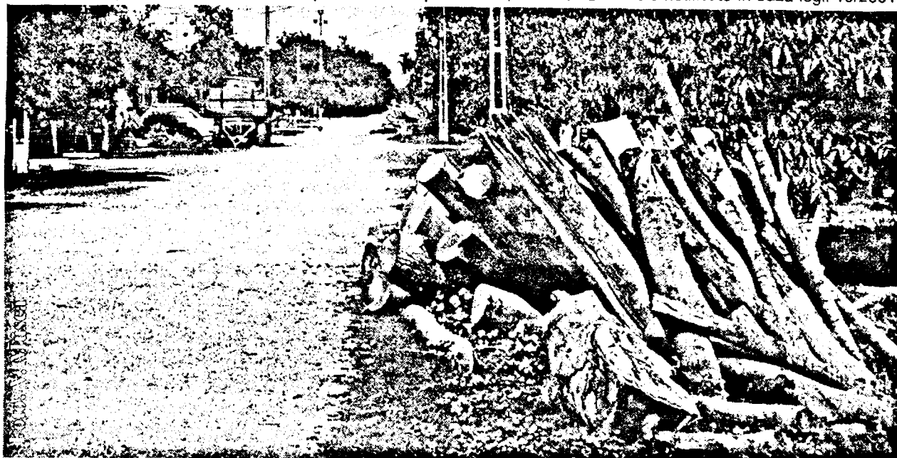
Ca să se poată săpa șanțurile, prima dată trebuie curățat domeniul public!
