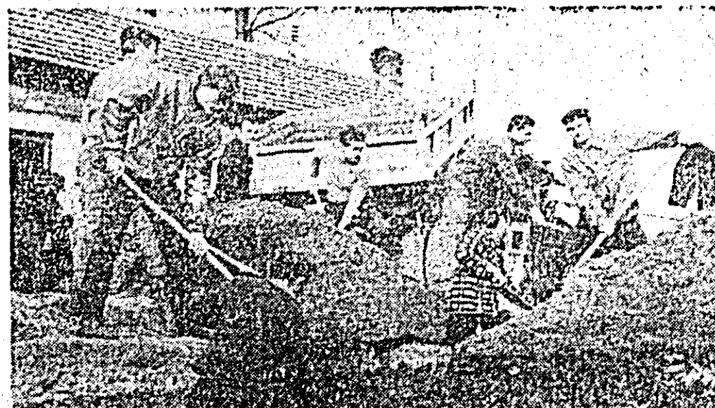
Muncitorii de la Uzina de strunguri, beneficiarii al viitorului bloc, la turnarea fundației.
