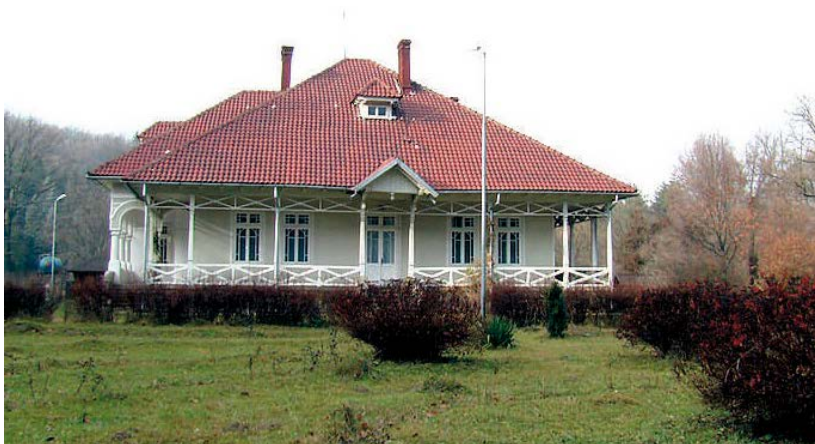
Clădirea Ocolului silvic Doftena unde a locuit ing. Iuliu Moldovan
