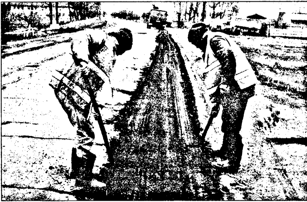
Pe raza localității Pecica, se lucrează la refacerea îmbrăcăminții asfaltice a șoselei naționale. Era și timpul...
