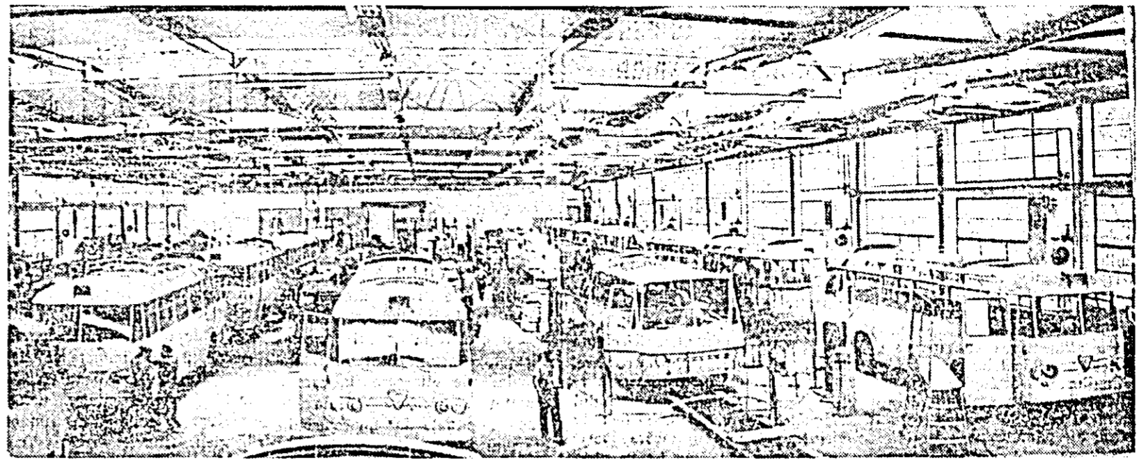
Noua hală de montaj a Uzinei „Autobuzul” din Capitală
