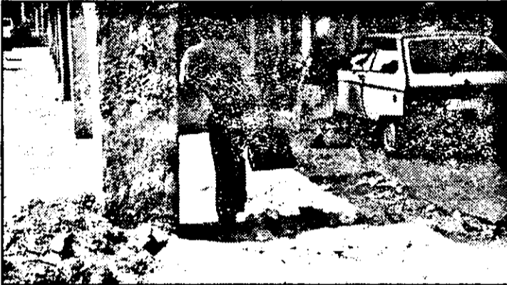
Mai acum o lună, o echipă de la CET a efectuat înlocuirea unei conducte subterane în fața blocului A 8 din Calea Aurel Vlaicu. După terminarea lucrării, precum pisica, lucrătorii au astupat în grabă groapa, cu pământ, lăsând refacerea trotuarului degradat de ei pe seama cui s-o nimeri. Parcă în această privință există o lege și o primărie care ar trebui să-și spună cuvântul. Așteptăm.
