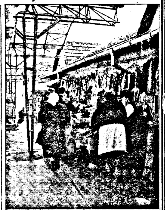
După „reparații” apa de pe acoperiș udă și mai tare marfa comercianților
