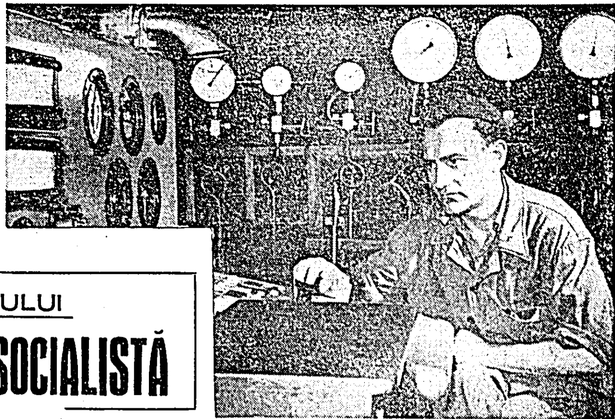
In sala de mașini a Uzinei electrice lucrează mecanicul principal de turbini, comunistul Aurel Ecsi. Munca lui atentă și conștiințoasă la pupltru de comandă, contribuie la buna aprovizionare a orașului cu energie electrică.
