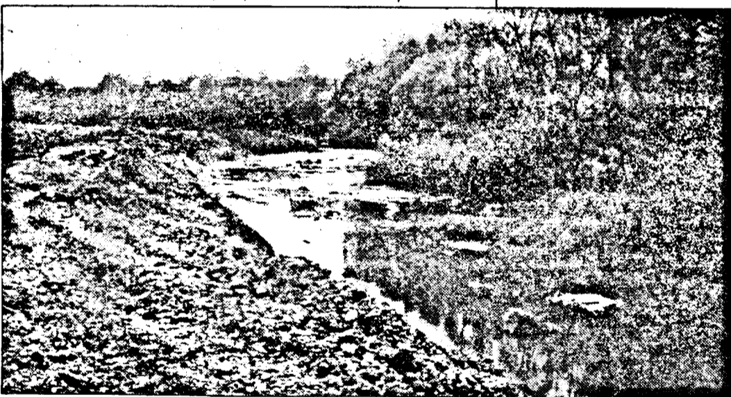
Lucrările pe Valea Crișului... în plină desfășurare
