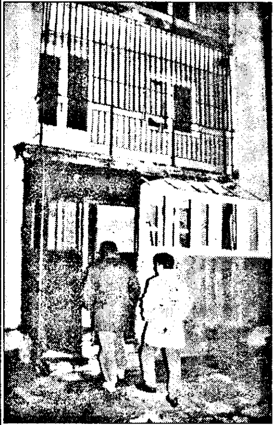
Căminul studențesc de pe str. Ursului, proaspăt renovat. Se mai lucrează doar la cabina portarului.
