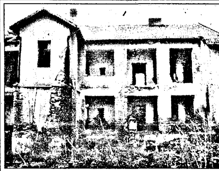
Imobilul de pe B-dul. Iuliu Maniț nr. 78 a fost, pe rând, casă parohială, depozit și adăpost pentru țigani. Acum este ceea ce se vede: ruină părăsită. Foto: V. MÛSCA
