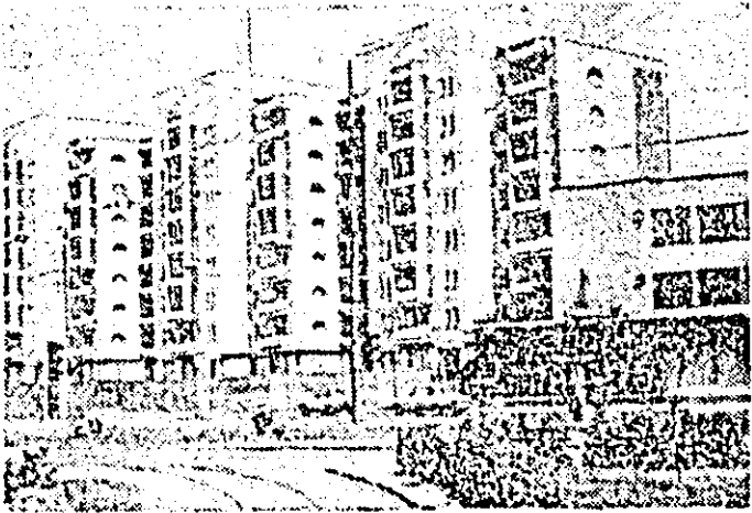
Sporește continuu zestrea edificată a municipiului. În imagine: noi blocuri de locuințe pe Calea Aurel Vlaicu.
