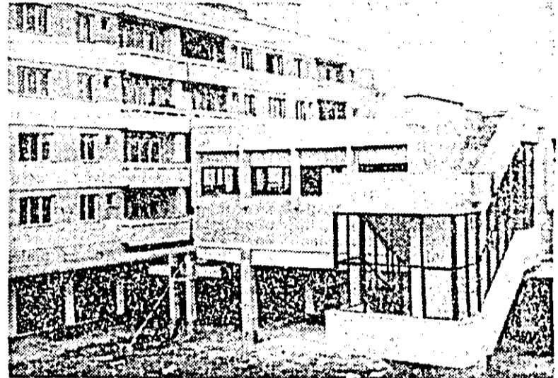
Un nou și modern bloc de locuințe, cu spații comerciale la parter, construit în Piața Arelor, va fi dat în curînd în folosință.
