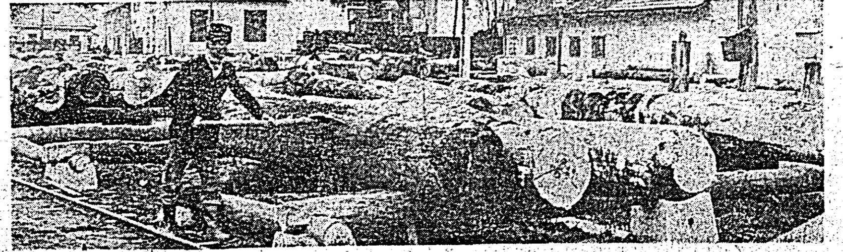
La fabrica de cherestea și parchete din Arad sosesc zilnic sute de bușteni. Transformați în scîndură, aceștia vor lua drumul fabricilor de mobilă sau spre alți beneficiari. Clieul de sus înfășează de pozitivul de bușteni, loc unde se face sortarea pe esențe și calități.
