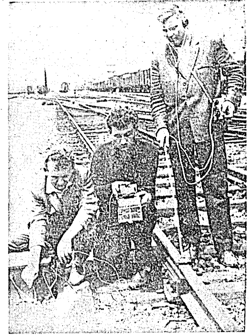
În fotografia noastră îl puteţi vedea pe tovarăşii Ing. Gheorghe Stana, Ioan Danjoş şi Petru Sira de la sectorul de centralizare electrodinamică a staţiei CFR, determinînd scurtcircuitul într-o secţiune izolată, cu ajutorul unui aparat electronic cu tranzistori.
